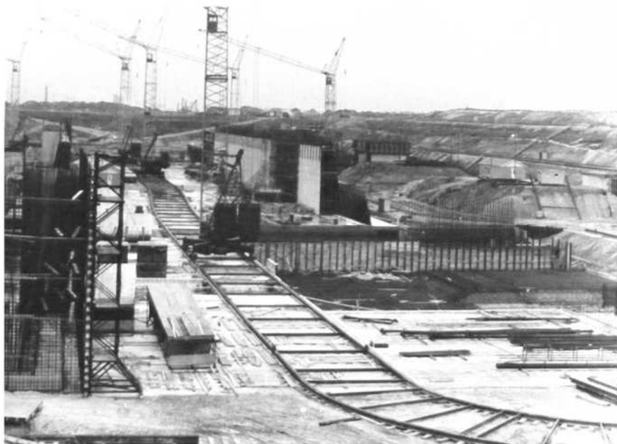
Graafwerken aan de nieuwe sluisen
